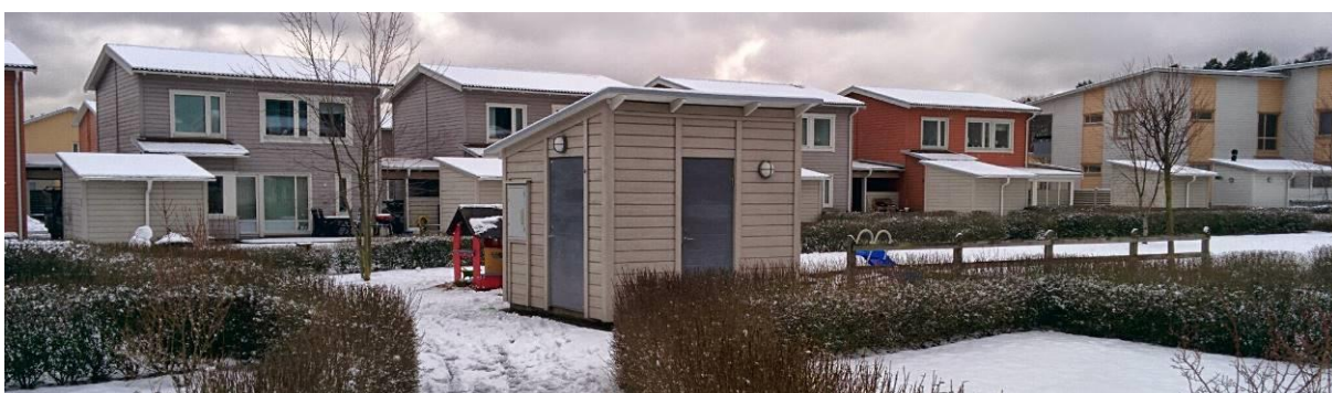
Förråd på innergården
