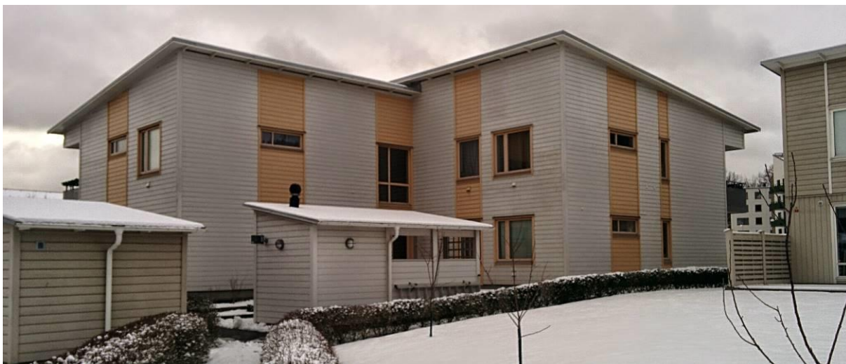
Flerfamiljshuset baksida, med tillhörande förråd och cykelställ
