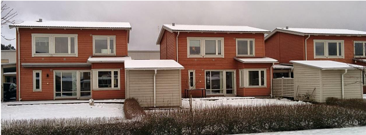
Vy från baksidan med förråd.
