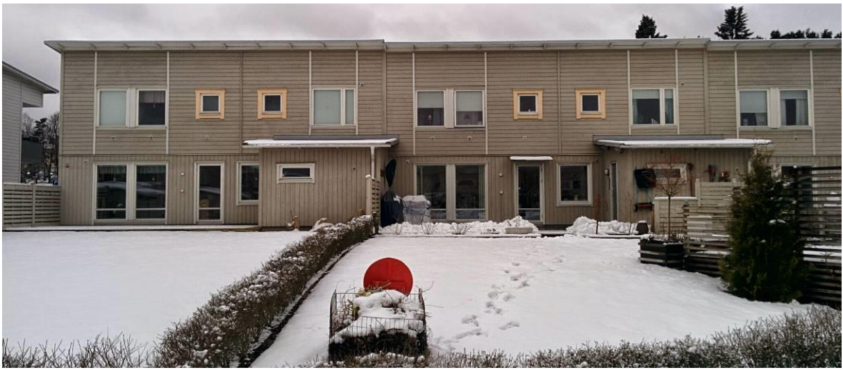
Vy från baksidan med förråd.
